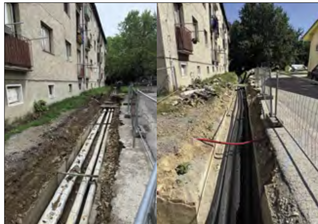
▲ Obr. 3 ● Výměna starých ocelových potrubí za flexibilní předizolované potrubí NRG AustroPUR
