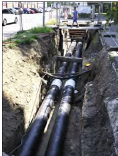
▲ Obr. 9 ● Předizolované ocelové potrubí s difúzní bariérou [5]
