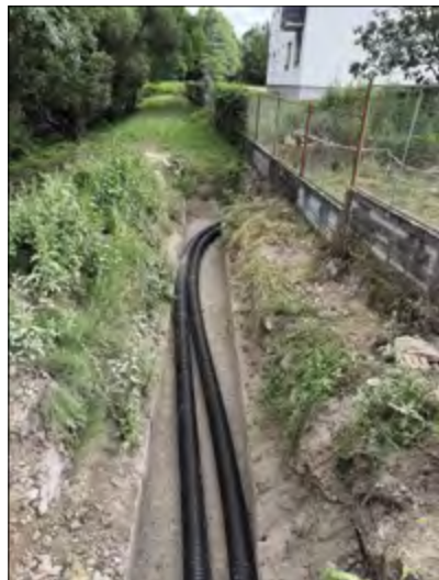
▲ Obr. 1 ● Nový rozvod ústředního vytápění v ZŠ Robotnická, NRG AustroPUR
