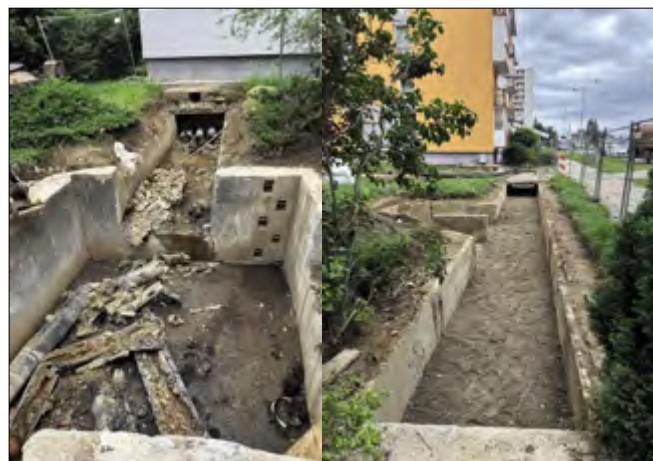
▲ Obr. 4 ● Demontáž původního ocelového potrubí
