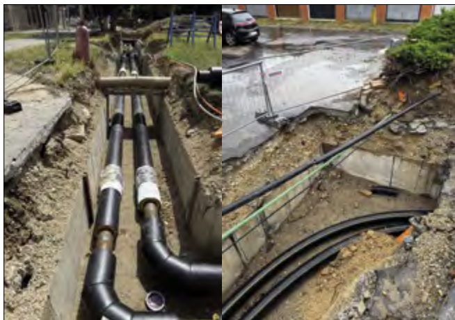
▲ Obr. 5 ● Příklad realizace etapy v ocelovém potrubí DN200 (levý obrázek) a v provedení z flexibilního potrubí NRG FibreFlex d160 (pravý obrázek), ulice Továrenská ve Zlatých Moravcích
