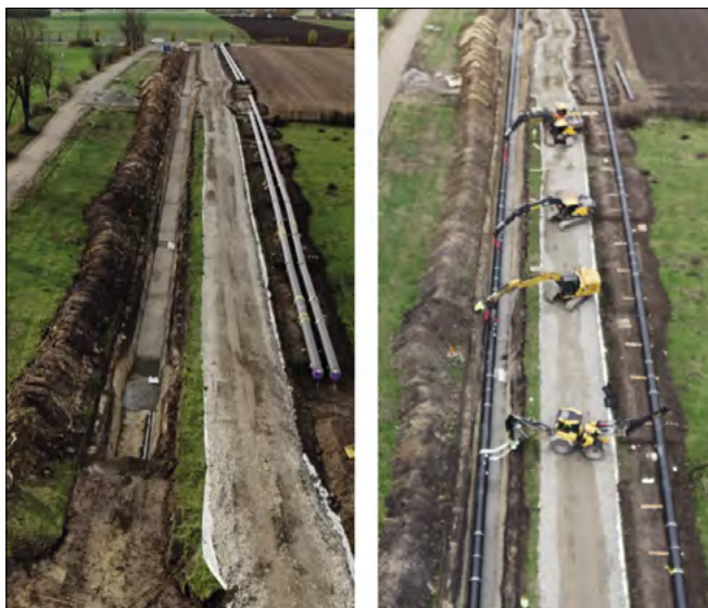
▲ Obr. 8 ● Metoda realizace „slank“ v rámci projektu ve Švédsku pro potrubí DN600 v délce 18 metrů
