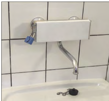
▲ Obr. 3 ● Kryt vodovodní baterie se zámek pro odběr vzorků vody po stagnaci (bod A1)
