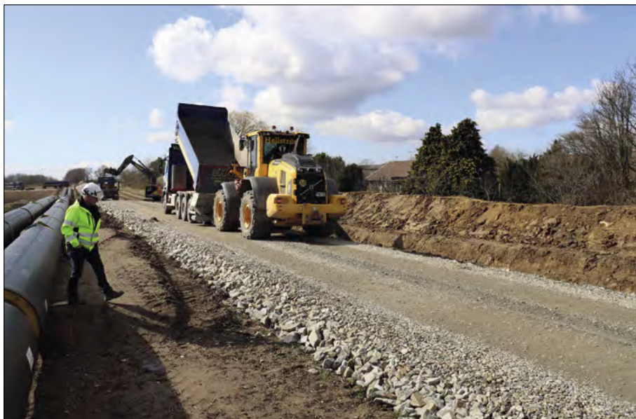
▲ Obr. 7 ● Realizace tranzitního potrubí
