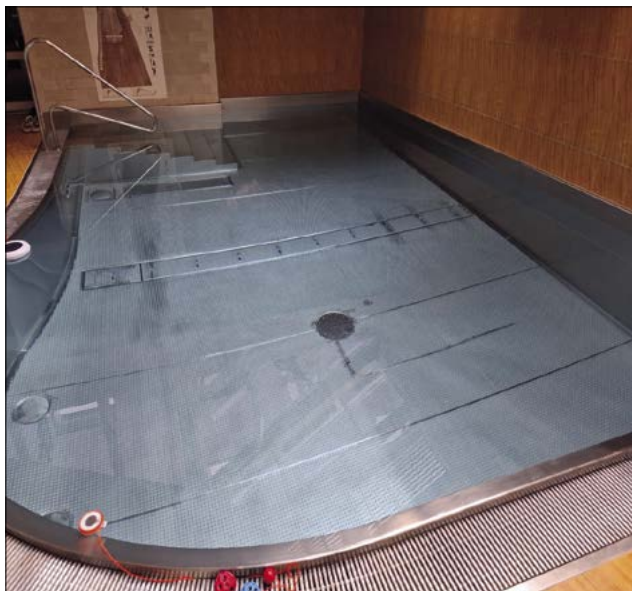
▲ Obr. 2 ● Vnitřní bazén vyhříváný solární technikou
