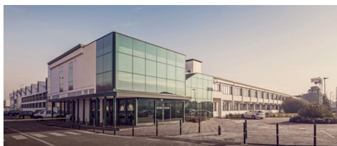
Centrála DAB PUMPS – Mestrino-Padova Itálie
