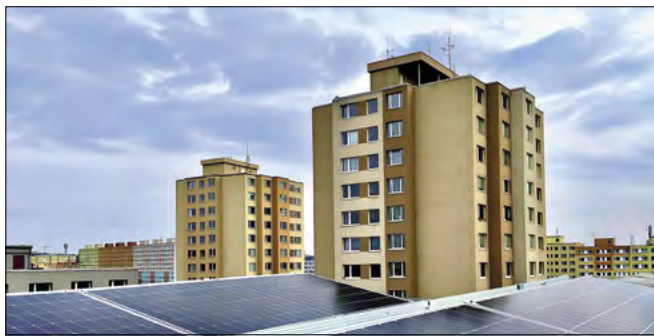
▲ Obr. 3 ● FVE na střeše bytového domu významně snižuje náklady na energie
