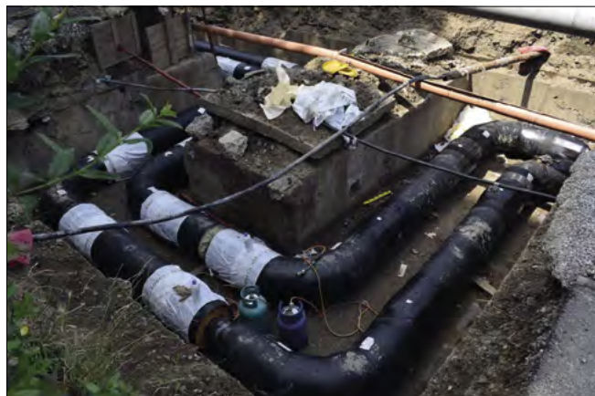
▲ Obr. 6 ● Kompenzace předizolovaného ocelového potrubí na trase [1]
