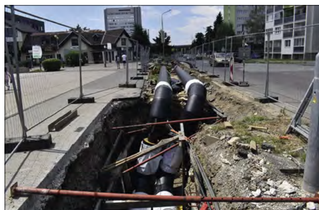
▲ Obr. 4 ● Rekonstrukce horkovodu v Humenném [1]
