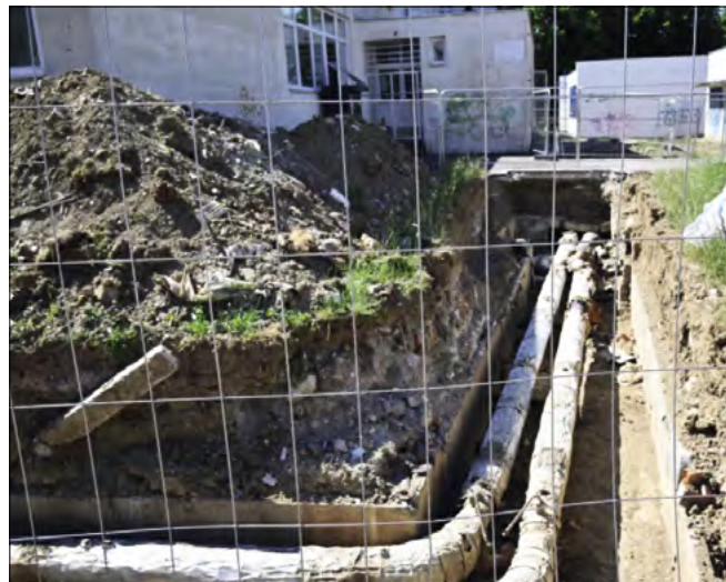
▲ Obr. 2 ● Původní ocelové potrubí [3]
