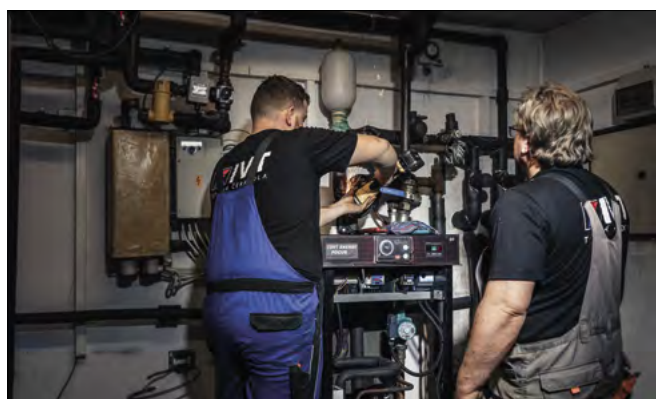
▲ Obr. 1 ● Výměna čerpadla IVT po 27 letech provozu
