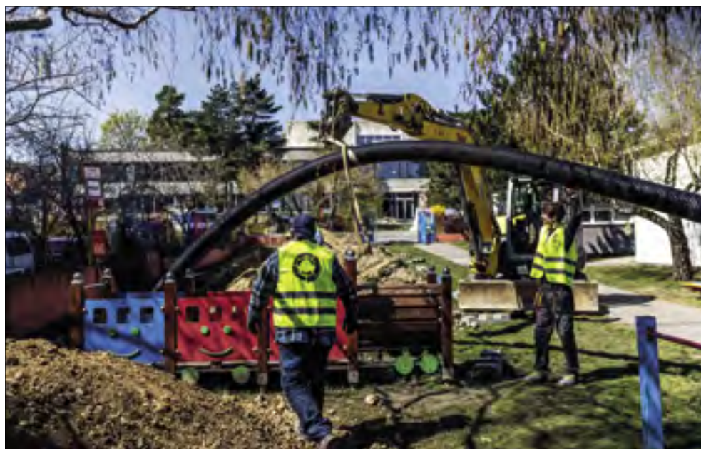
▼ Obr. 4 ● Realizace napojení potrubí
