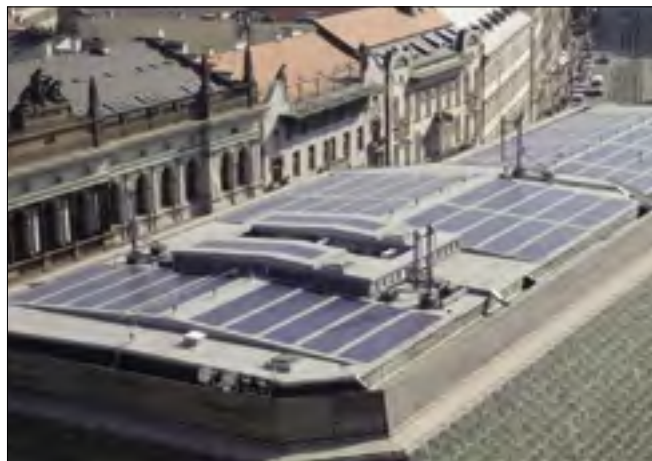
▲ Obr. 2 ● Fotovoltaické panely na střeše Nové scény [1]
