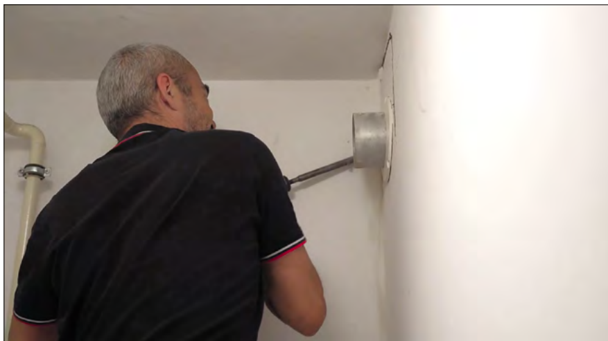
▲ Obr. 4 ● Demontáž původního kouřovodu
