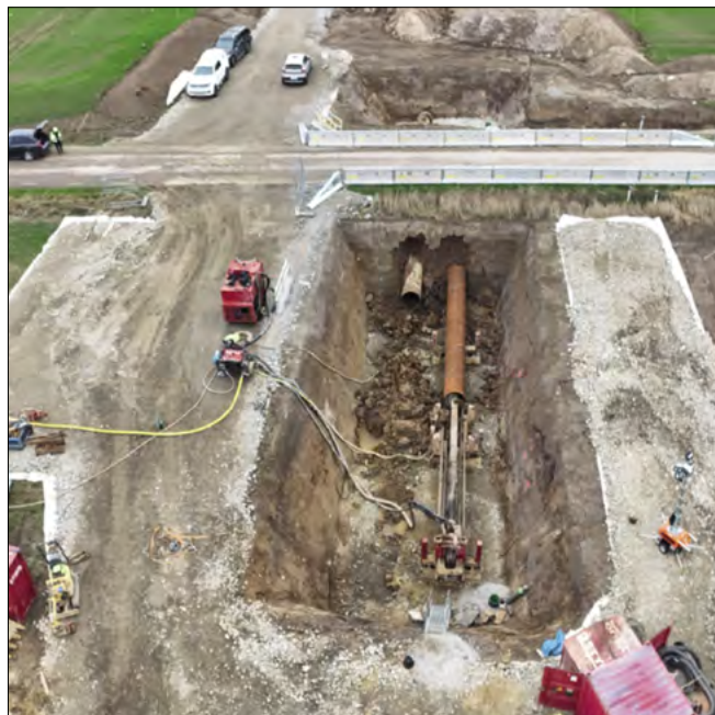
▲ Obr. 5 ● Bezvýkopová realizace pod komunikací
