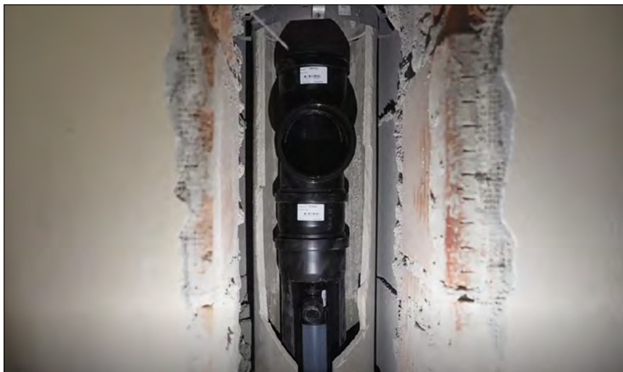
▲ Obr. 7 ● Provedení komínové jímky a kontrolního otvoru
