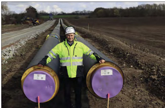
▲ Obr. 2 ● Ocelové potrubí v dimenzi DN600 realizované v Švédsku
