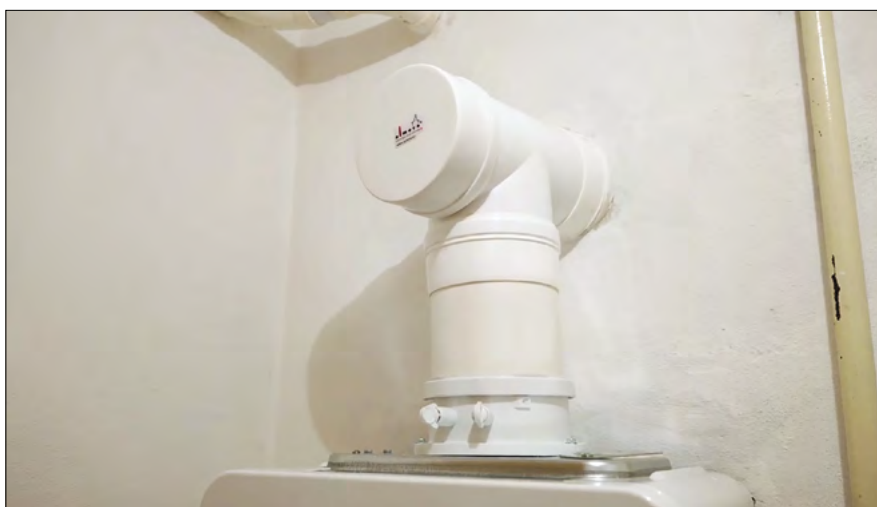
▲ Obr. 8 ● Výsledné dopojení kotle do společného komínu po zapravení otvorů
