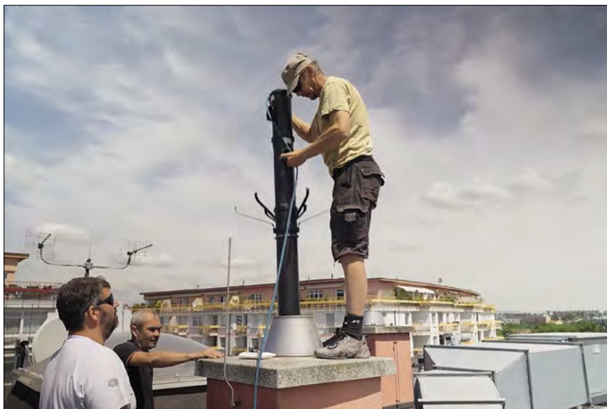
▼ Obr. 6 ● Spuštění komínové vložky
