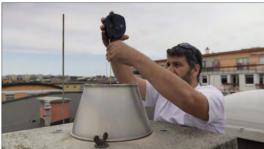
▲ Obr. 5 ● Zaměření skutečných výšek sopouchů
