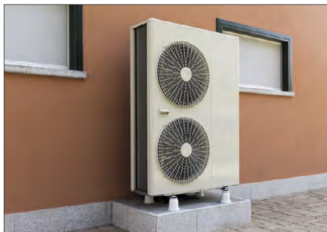
▲ Obr. 1 ● Venkovní jednotka tepelného čerpadla
