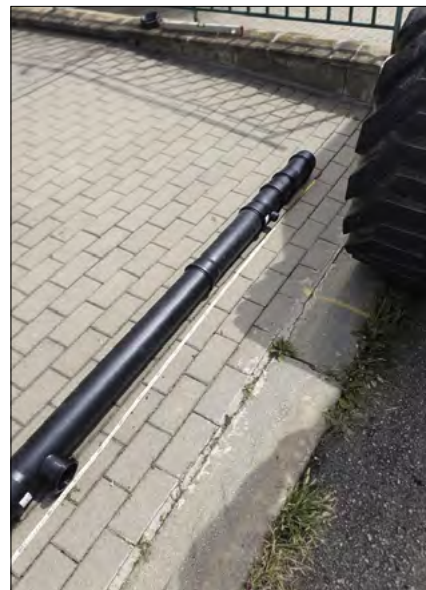
▲ Obr. 6, 7 ● Ukázka rozměření a složení vložky nanečisto
