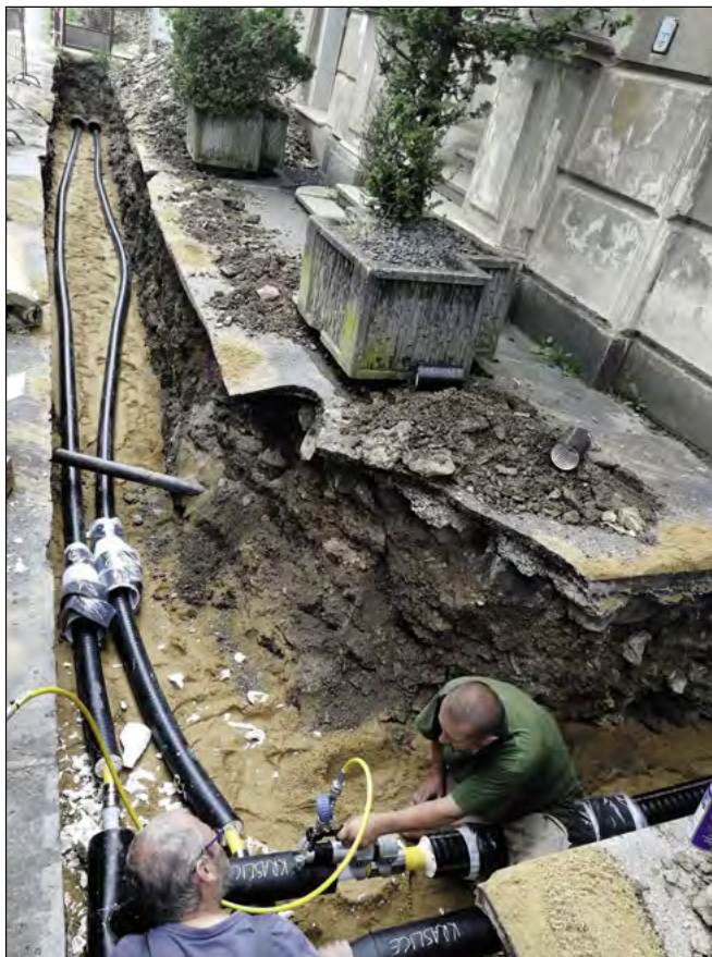
▲ Obr. 4 ● Fotografie z realizace přípojky ve městě Kraslice
