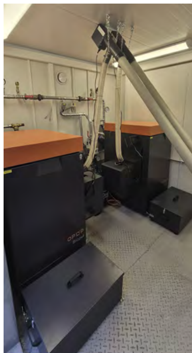
▲ Obr. 1 ● Kaskáda dvou peletových kotlů Biopel o výkonech 60 kW pro mateřskou školu ve Vandzene (Lotyšsko)
