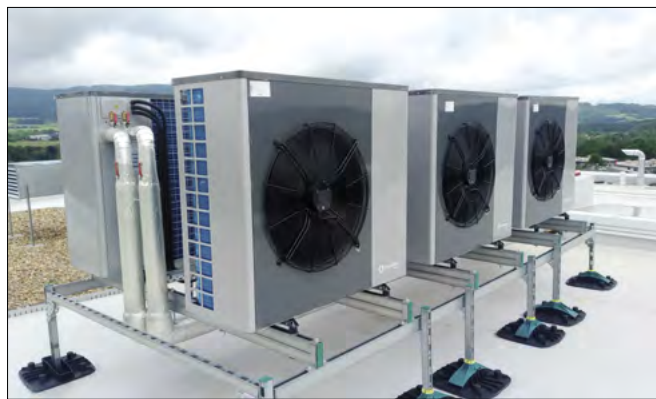
▲ Obr. 1 ● ECOFOREST ecoAir – kaskádní zapojení venkovních jednotek do jednoho sběrného potrubí
