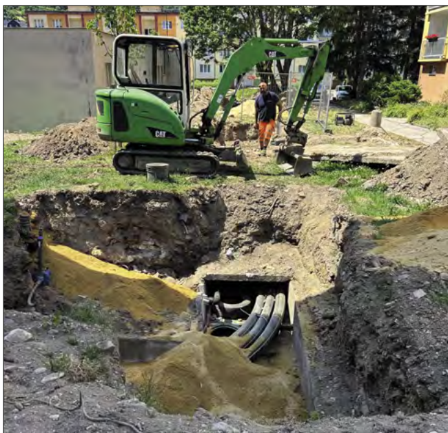
▼ Obr. 6 ● Realizace rozvodů ústředního vytápění a teplé vody ve městě Kraslice
