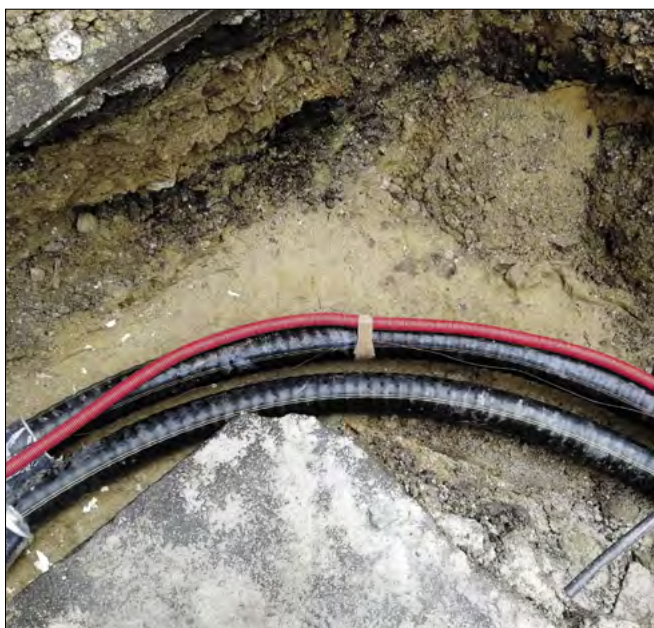
▲ Obr. 5 ● Ohyb předizolovaných plastových potrubí
