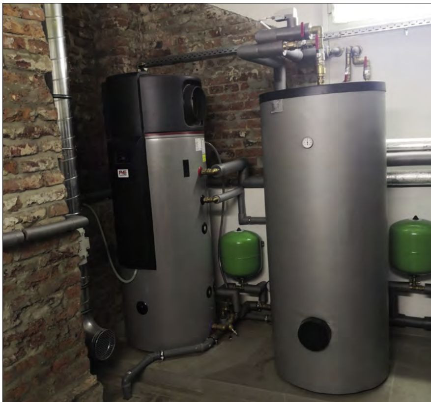
▲ Obr. 7 ● Instalace tepelného čerpadla pro přehřev teplé vody v ZŠ Tábořská
