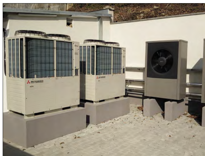
▲ Obr. 2 ● MHI Q ton – díky chladivu CO 2 ohřívá teplou vodu levněji než čerpadla s jinými chladivy
