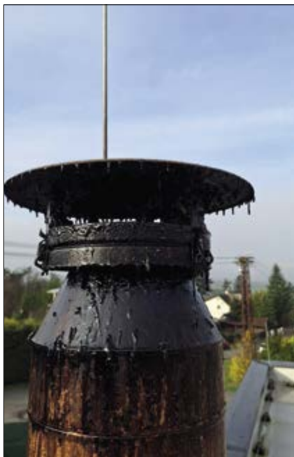
▲ Obr. 10 ● Ukázky tzv. zadehtovaného svislého kouřovodu s funkcí komínu
