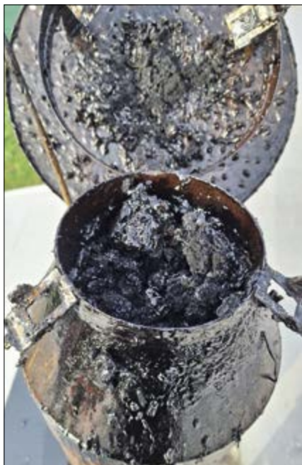
▲ Obr. 10 ● Ukázky tzv. zadehtovaného svislého kouřovodu s funkcí komínu
