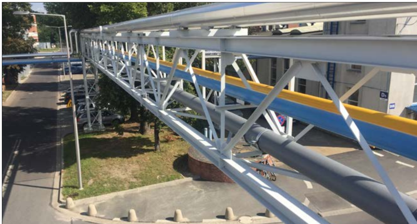
▼ Obr. 7 ● Předizolované potrubí NRG RADPOL UV PROTECT instalované v exteriéru
