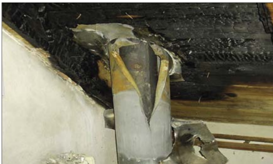
▲ Obr. 3 ● Špatná kvalita individuálního komínu a jeho nevhodné zabudování
