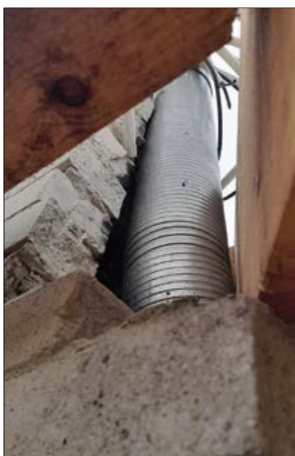
▼ Obr. 5 ● Dodatečně vlozkovaný komín a plánované zazdění trámu přímo ke komínové vložce
