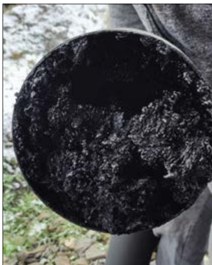
▲ Obr. 13 ● Zadehtovaný kouřovod
