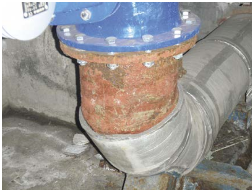
▲ Obr. 13 ● Použitá tloušťka izolace z pěnového polyetyleny 10 mm je pro vyšší relativní vlhkosti nedostatečná – pro okrajové podmínky uvedené v tab. 2 zabráni povrchové kondenzaci jen při \text{RH} \leq 70\%
