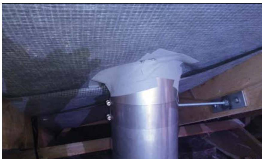
▲ Obr. 2 ● Parozábrana přilepená přímo na komínové těleso
